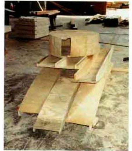
Bild 6: Schalungsbau ist fester Unternehmensbestandteil
