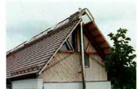
Bild 12: Außenansicht Kindergarten Langgöns
