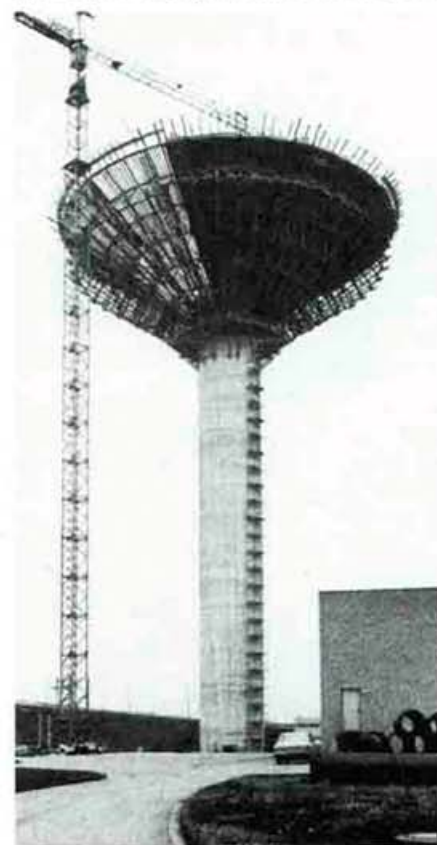
Bild 2: Wasserturm in Leverkusen, die Statik für das Lehrgerüst machte Rinn 1975 auf 23 Seiten »von Hand«
