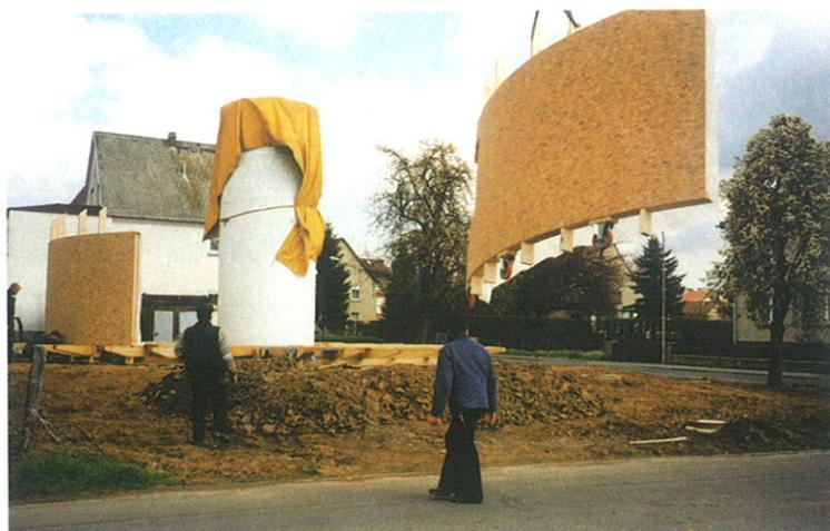
**Bild 10:** Montage der vorgefertigten Außenwandelemente auf den Deckenbalken der drehbaren Kellerdecke. Die Stützrollen sind werkseitig am Wandelement befestigt.
