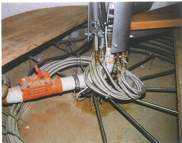
**Bild 9:** Gebündelte Installationsführung in der Spindel der Treppe
