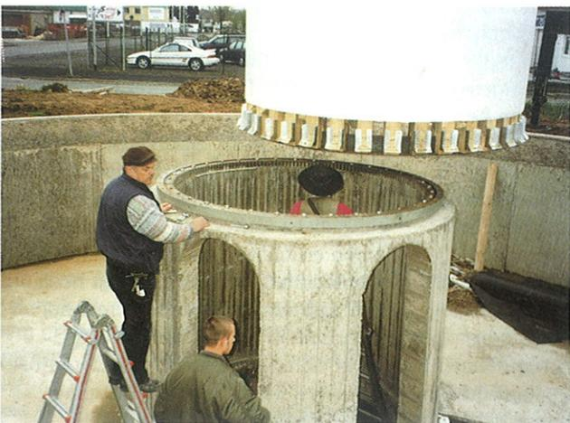
**Bild 7:** Die „hölzerne“ Mittelsäule des Erd- und Dachgeschosses wird zur Montage eingeschwenkt. Deutlich erkennbar ist der als Großkugellager dienende stählerne Drehkranz und die für die Deckenauflagerung vorgesehene Balkenschuhe.
