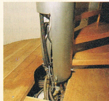
Im zentralen Treppenhausschacht werden die Versorgungsleitungen vom Keller nach oben geführt.
