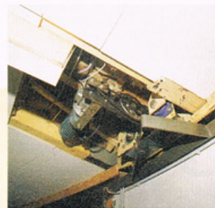
Ein 200-Watt-Motor dreht das Haus, so dass es dem Stand der Sonne folgen kann. (Foto rechts)
