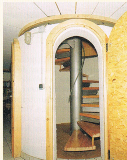
Im zentralen Treppenhausschacht werden die Versorgungsleitungen vom Keller nach oben geführt.
