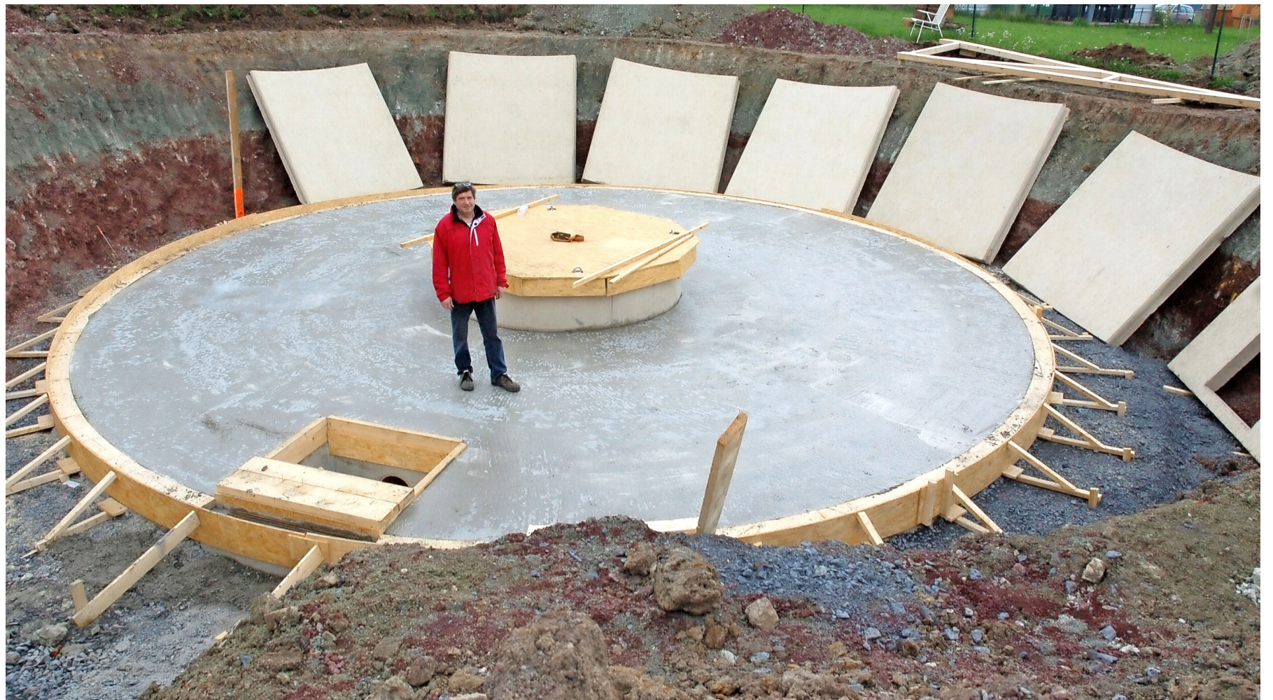
Rolf Friedenstab steht auf der Grundplatte, die später einmal sein Drehhaus tragen soll.
