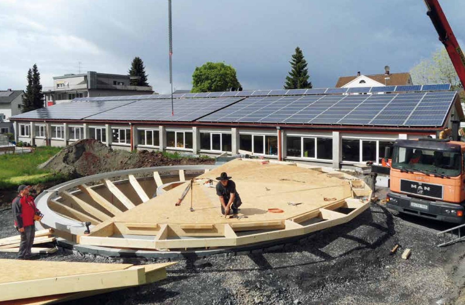
▲ Hier ist der Keller in Coburg fertig. Gerade wird der drehbare Boden aus OSB-Platten montiert
