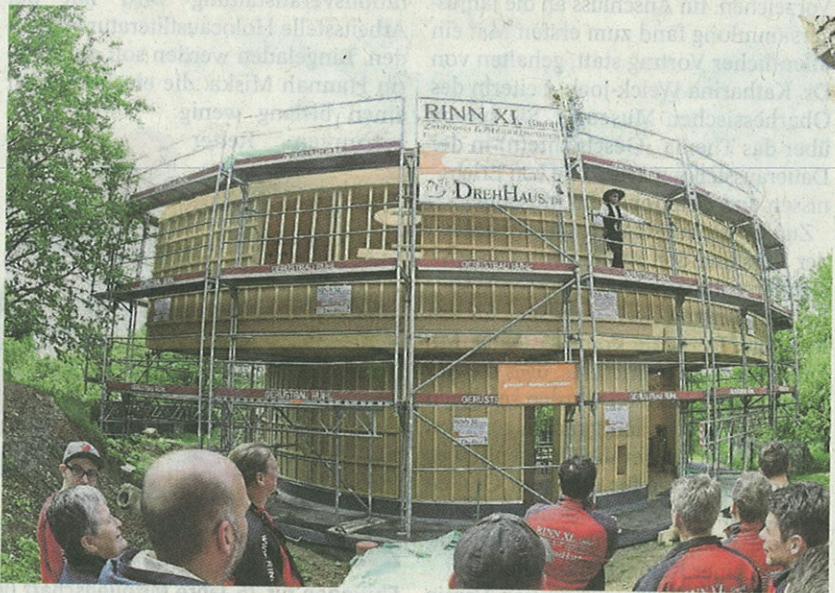
Am Drehhaus wird Richtfest gefeiert.
