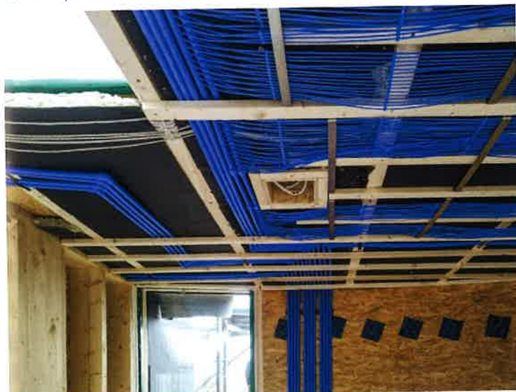
Clina Kapillarrohrmatten Einbausituation
