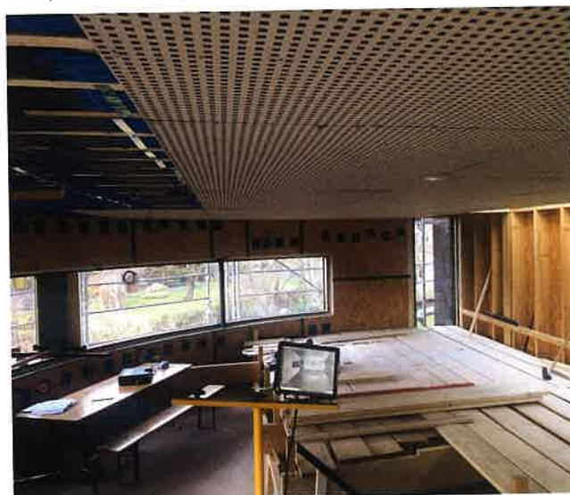
Heiz-/Kühldecke, Beplankungsphase ©DrehHaus GmbH
