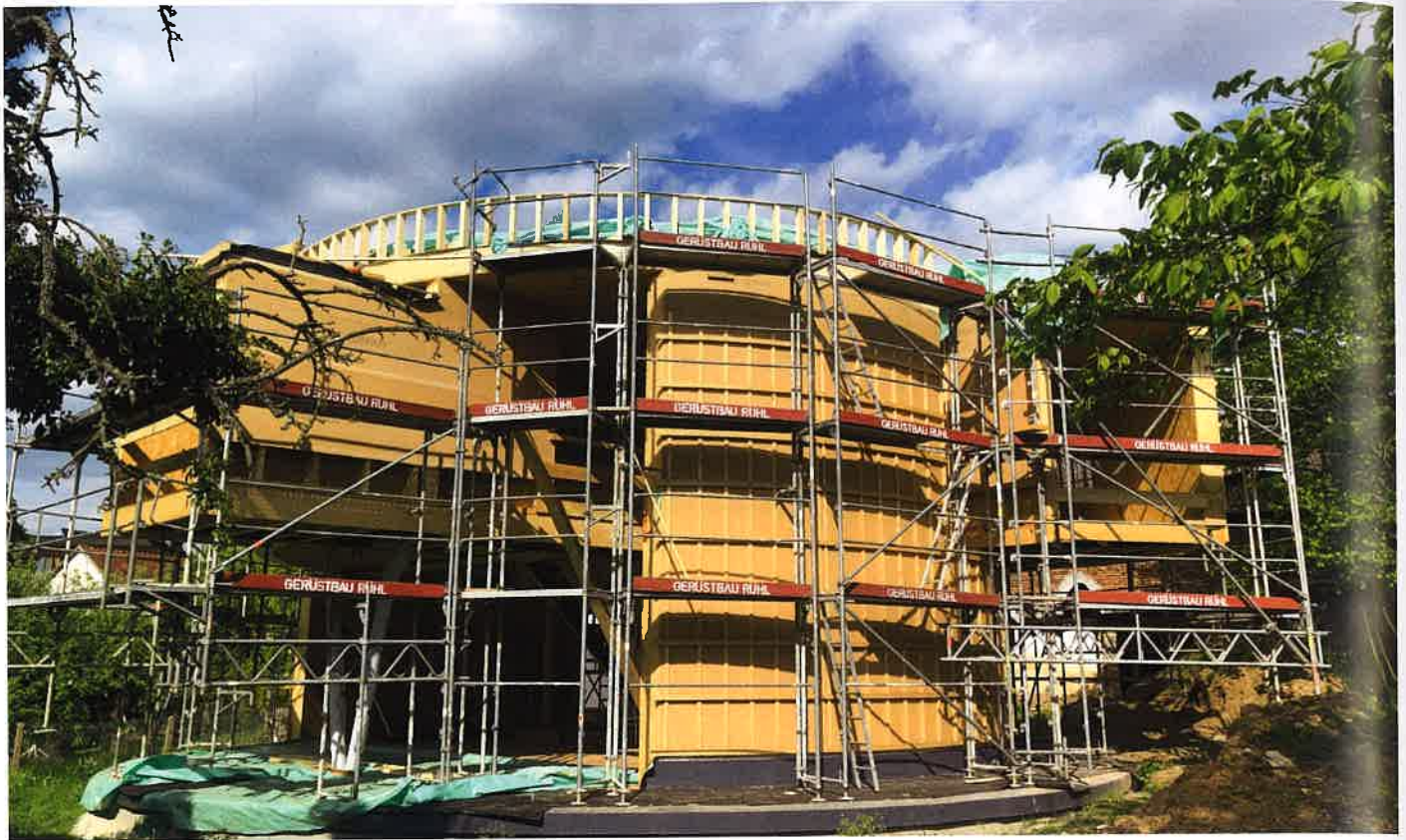
Drehhaus Nr. 4 im Bau © DrehHaus GmbH
