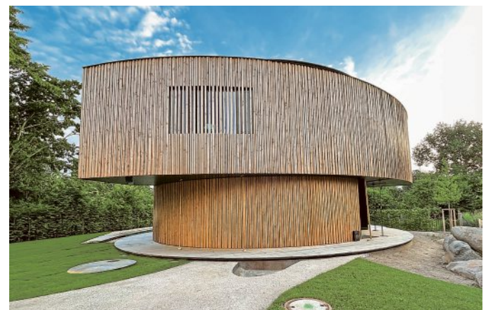
Vor den Fenstern fehlt jede zweite Latte in der Verkleidung: Hinausschauen geht, hineinschauen aber nicht, da der Abstand zwischen den Brettern kleiner ist als der zwischen den Augen.
