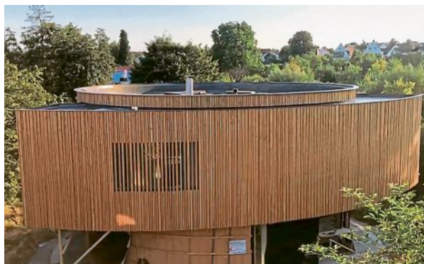
Vor den Fenstern fehlt jede zweite Latte in der Verkleidung: Hinausschauen geht, hineinschauen aber nicht, da der Abstand zwischen den Brettern kleiner ist als der zwischen den Augen.
