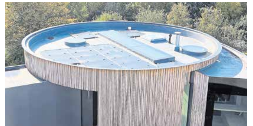
Weil sich das „DrehHaus“ selbst nach der Sonne ausrichten kann, spielt der Einstrahlungswinkel der Photovoltaikanlage auf dem Flachdach keine Rolle.
