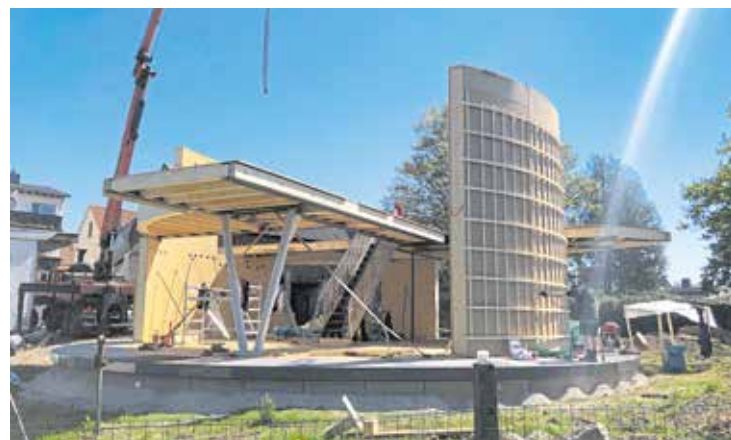
Aufbau der Holzrahmenkonstruktion: Das „DrehHaus“ ist das erste, das sich trotz aller Anschlüsse endlos in beide Richtungen drehen kann.
